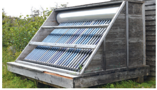
सोलर वॉटर हीटर, सोलर उत्पादों में सबसे पुराना है। घरेलू इस्तेमाल के लिए 100 से 300 लीटर क्षमता का सोलर हीटर पर्याप्त होता है।
